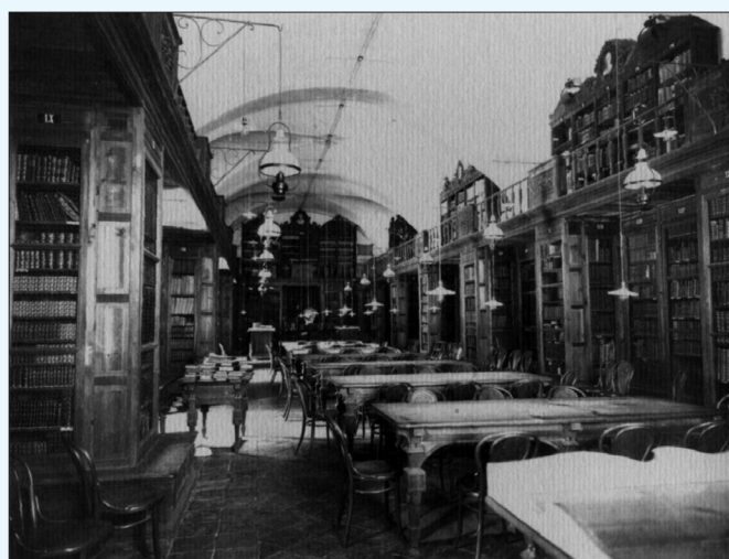
BIBLIOTECA “José María Lafragua” abierta al público el 16 de septiembre de 1885, Los espacios del saber. El edificio Carolino en los años treinta del siglo XX (lámina 5).
